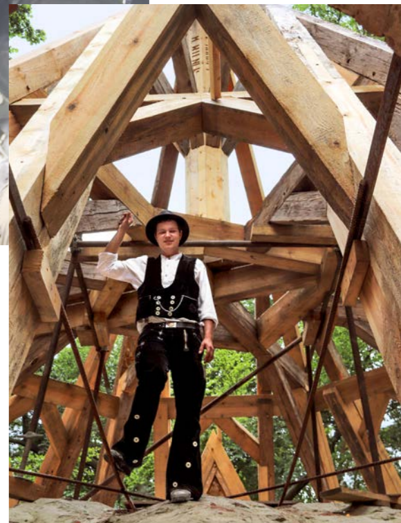
In Ostpolen erneuerte Marius Wiener mit drei weiteren Wandergesellen ohne schweres Gerät den Dachstuhl eines Mausoleums.
