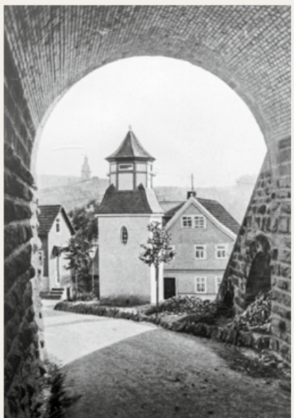
Die Trafostation Am Domberg in Suhl passt sich um 1930 gut ins Ortsbild ein.
