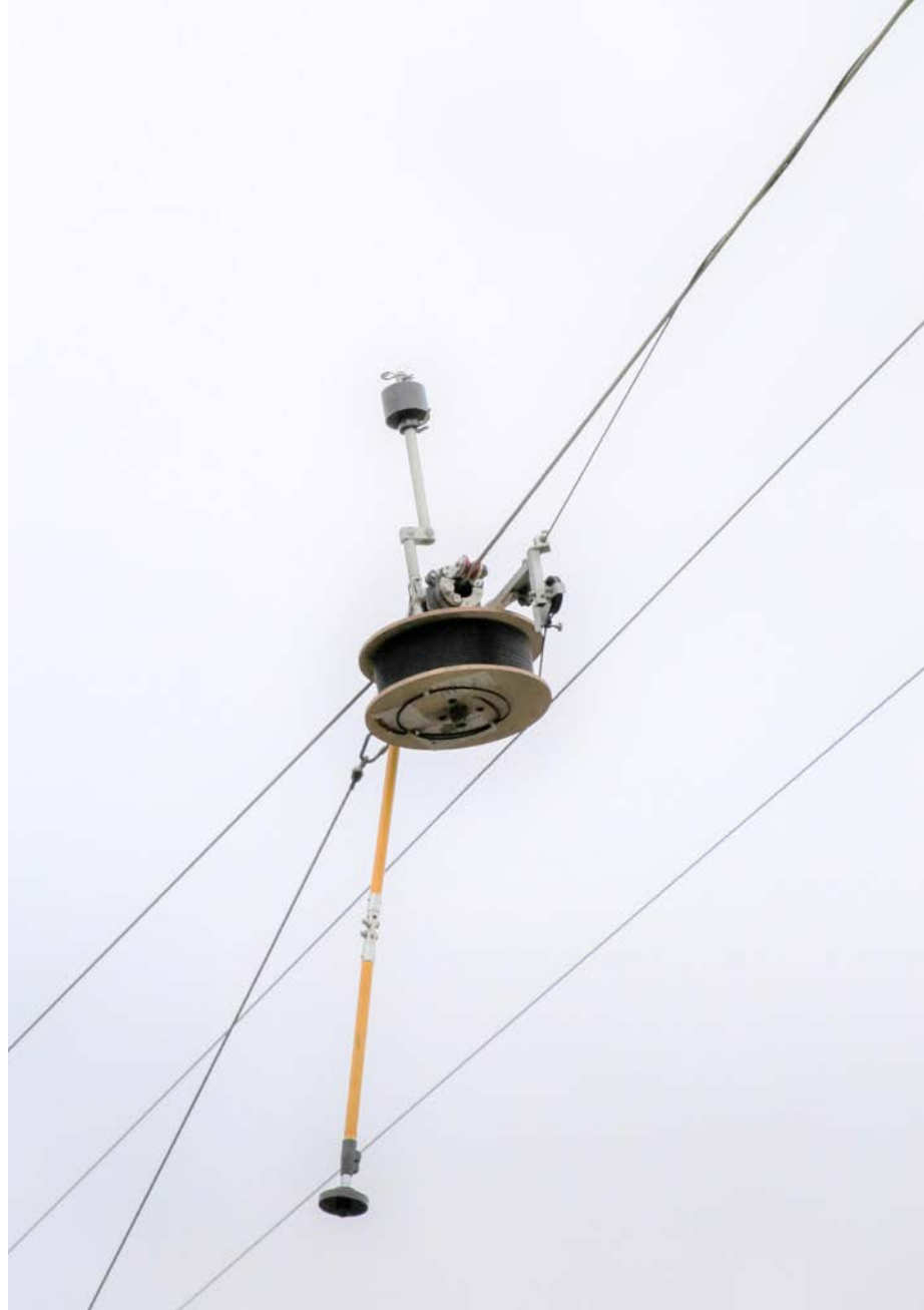
Speziell entwickelter Rollwagen im Einsatz: Per SkyWrap-Verfahren werden Glasfaserleitungen ohne umfangreiche Baumaßnahmen um das Stromleiterseil gedriht.
